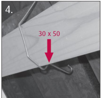
Bei Lattung 30 x 50 die Klammer bis zur zweiten Raste herunterdrücken.
