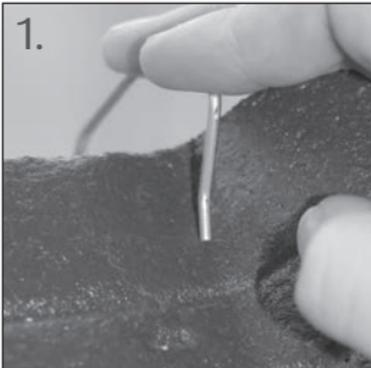
1. Bei Lattung 40 x 60 mm Klammerkopf von vorne über den Pfannenkopf setzen ...
