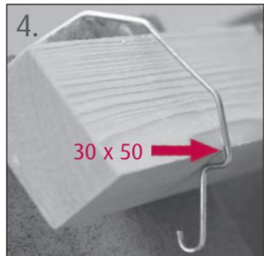
4. Bei Lattung 30 x 50 mm die Klammer bis zur zweiten Raste herunterdrücken.
