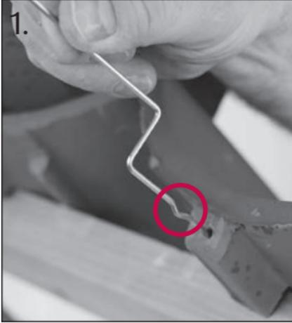
1. Hohlziegel auf Dachlatte auflegen. Klammer von oben in das Loch der Aufhängenase stecken.
