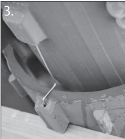
3. Nächsten Ziegel mit der Befestigungsnase in das freie Drahtende einschieben.
