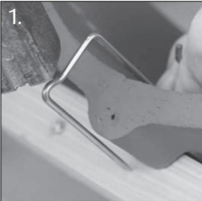
1. Klammer über den Kopf der Dachpfanne setzen und einschlagen.
