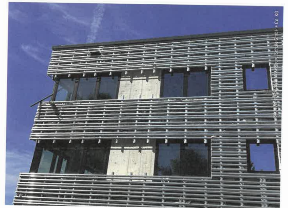
Die Unterkonstruktion aus Aluminium trägt später die Schiefer in dynamischer Deckung.
