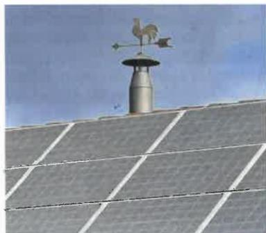
Aufdach-Photovoltaikanlage entbinden nicht von Windsogsicherung.
