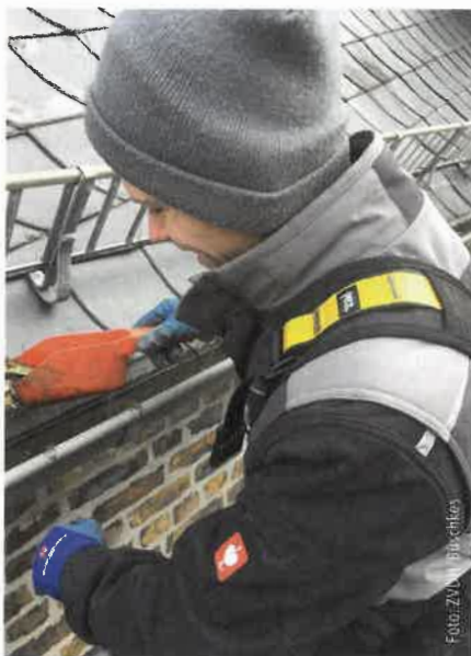
Auch das Reinigen der Dachrinnen gehört zur Wartung.
