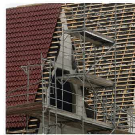
Dachneigung über 65°, Sanierung Kirche Stralsund
