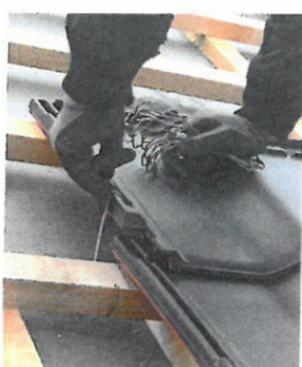
▲ Einfache Verarbeitung: Die Dachdecker mussten die Einhängeklammern zunächst in die Lattung hängen und anschließend in der Seitenverfaltung des jeweiligen Ziegels einhaken
