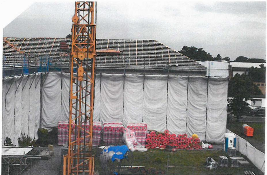
▲ Gut gesichert: Auf dem 2000 m<sup>2</sup> großen Dach wurde jeder Ziegel mit einer Sturmklammer befestigt
