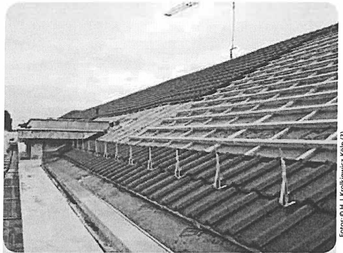
Die rund 2.000 m 2 große Dachfläche des VW-Werks in Braunschweig wurde umfassend saniert.
