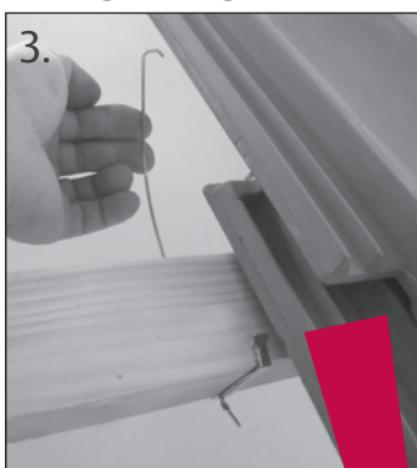
Placer la tuile et accrocher l'extrémité du fil dans la cannelure latérale.
