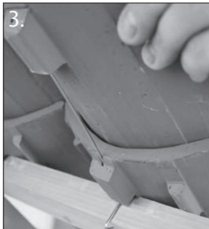
Nächsten Ziegel mit der Befestigungsnase in das freie Drahtende einschieben.
