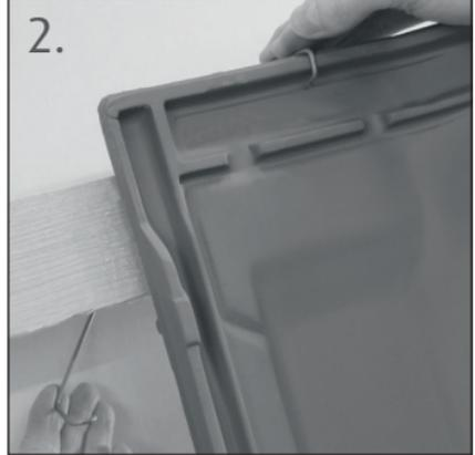
2. ... und von oben hinter die Dachlatte schieben. Oberes Ende auf den Kopffalz einhängen.
