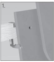
Jeden zweiten Biber der Lagerschicht mit der Klammer Typ 1 an der Traglatte befestigen.
