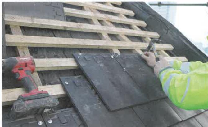
▲ ... zuverlässig gegen Windsog und Wirbelschleppen. Zusätzlich wurde jeder Ziegel am Kopfende auch noch mit zwei Schrauben fixiert
