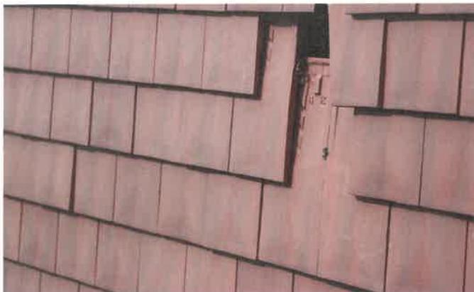
▲ Die Biberschwanzklammer 425-031 fixiert den Ziegel Edilians Stretto und ermöglicht den werkzeuglosen Austausch einzelner Ziegel
