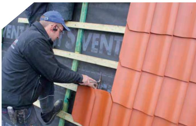
▲ Jeder der 17.000 Hohlziegel wurde mit einer Sturmklammer gesichert
