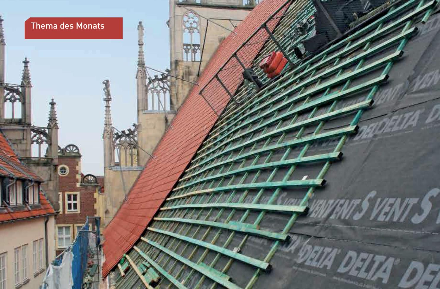
▲ Meter machen: Bei der Sanierung des mächtigen Satteldachs haben die Handwerker über 10 km Dachlatten zugeschnitten und montiert
