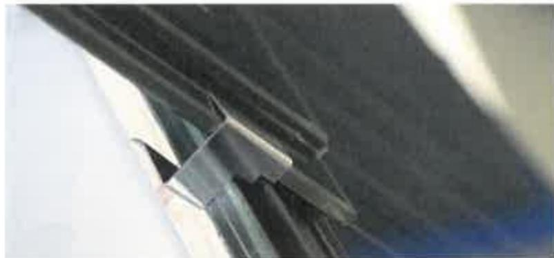
erfolgen. Gegen Windsog mit Sturmklammern zu sichern sind sowohl die Panels, die bei Indach-Lösungen die Dachpfannen ersetzen, als auch die Dachbereiche um eine PV-Anlage herum.
