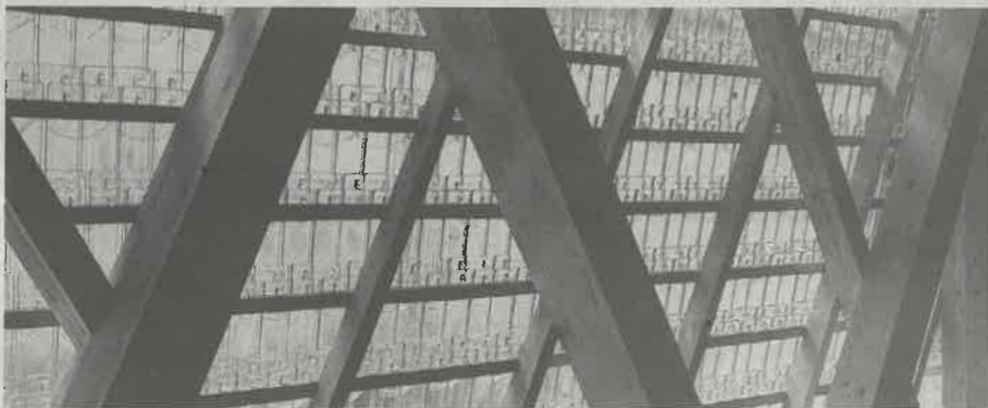
Der Neubau mit Holztragwerk und markanter Glashülle stabilisiert die denkmalgeschützte Bausubstanz des Reutlinger Heimatmuseums.
