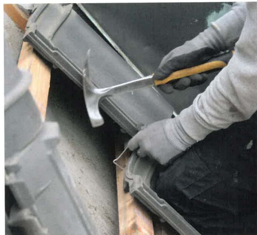
Dachdecker bei der Montage einer Sturmklammer.
