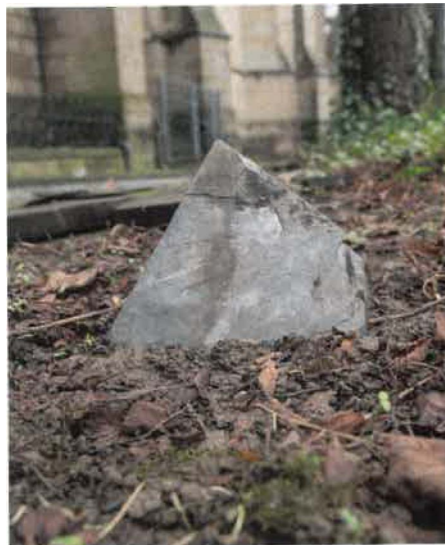
Herabfallende Dachpfannen können Sach- und Personenschäden verursachen.
