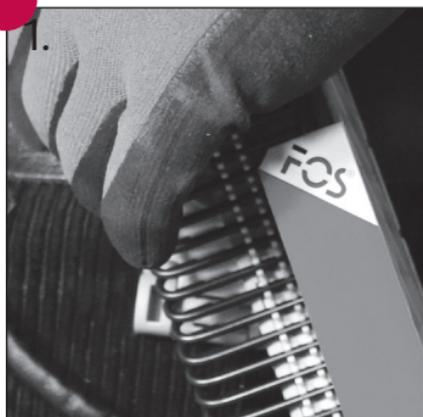
**1.** Bis zu 25 % Zeitersparnis bei der Montage mit dem FOS ClipHOLSTER. Haken von dem Magazinstreifen entnehmen.
