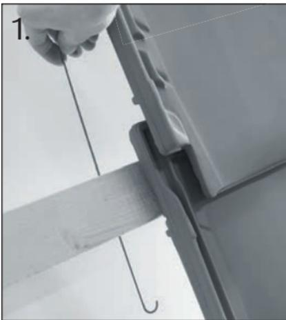
Klammer von oben hinter die Dachlatte führen.
