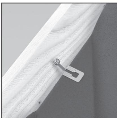
Die Grat- und Kehlklammer mit vormontierter Schraube an der Unterkonstruktion anschrauben.
