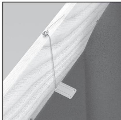
Pour l'aide au montage 513, fixer le fil d'attache en tension légère à une vis ou à un clou traité anticorrosion.
