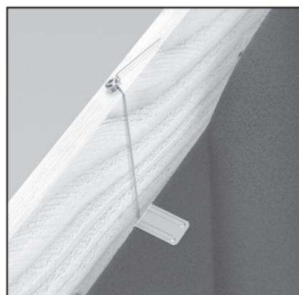
Bei dieser Grat- und Kehlklammer wird der Draht unter leichter Spannung an einer Schraube oder einem (mind.) korrosionsgeschützten Nagel befestigt.
