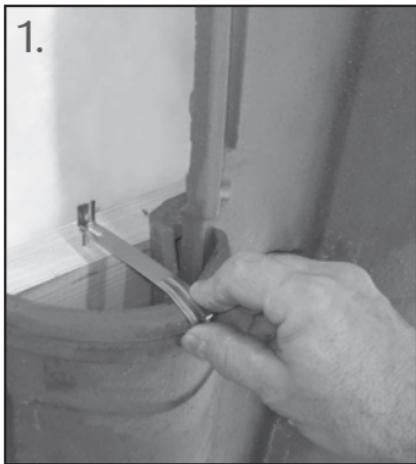
Klammerauge am höchsten Punkt des Ziegels an der Kopffalz positionieren.
