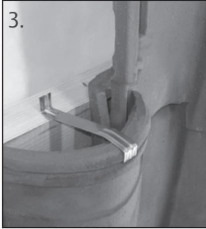
À la jonction de quatre tuiles, le crochet maintient trois tuiles à la fois.
