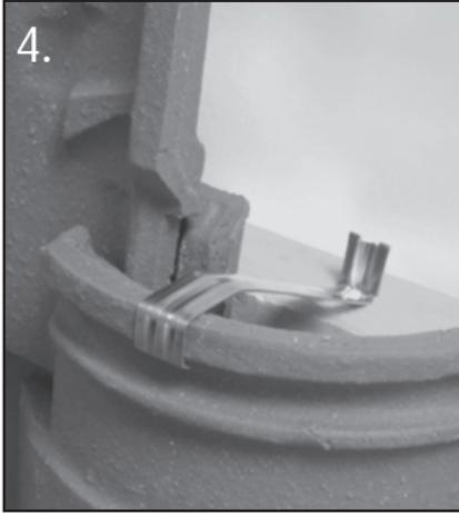
**Attention:** à n'utiliser que pour les tuiles à emboîtement droit et à emboîtement gauche, dont le haut recouvre la cannelure transversale.
