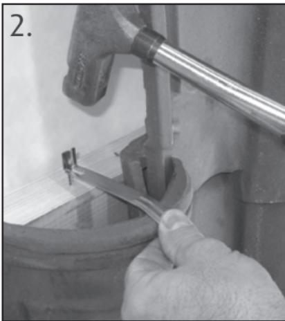
Gezackte Einschlagspitze senkrecht auf die Oberkante der Latte aufsetzen und einschlagen.
