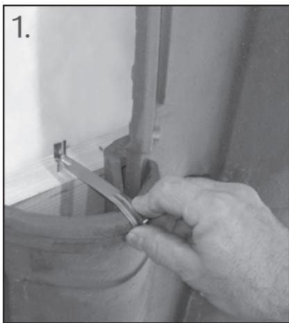
Positionner la broche supérieure du crochet le plus haut possible dans la cannelure transversale de la tuile.
