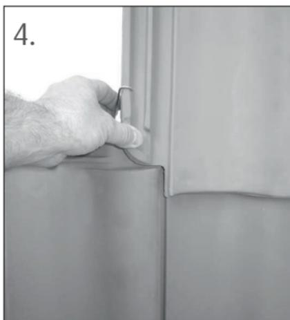
4. ... crocher la partie supérieure du crochet dans la rainure latérale. À la jonction de 4 tuiles le crochet maintient 3 tuiles à la fois.
