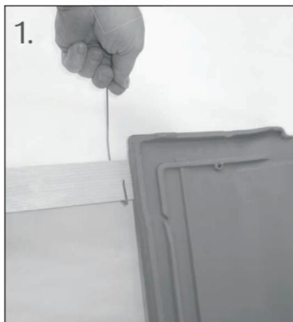
1. Positionner le crochet à l'arrière du liteau et tirer.
